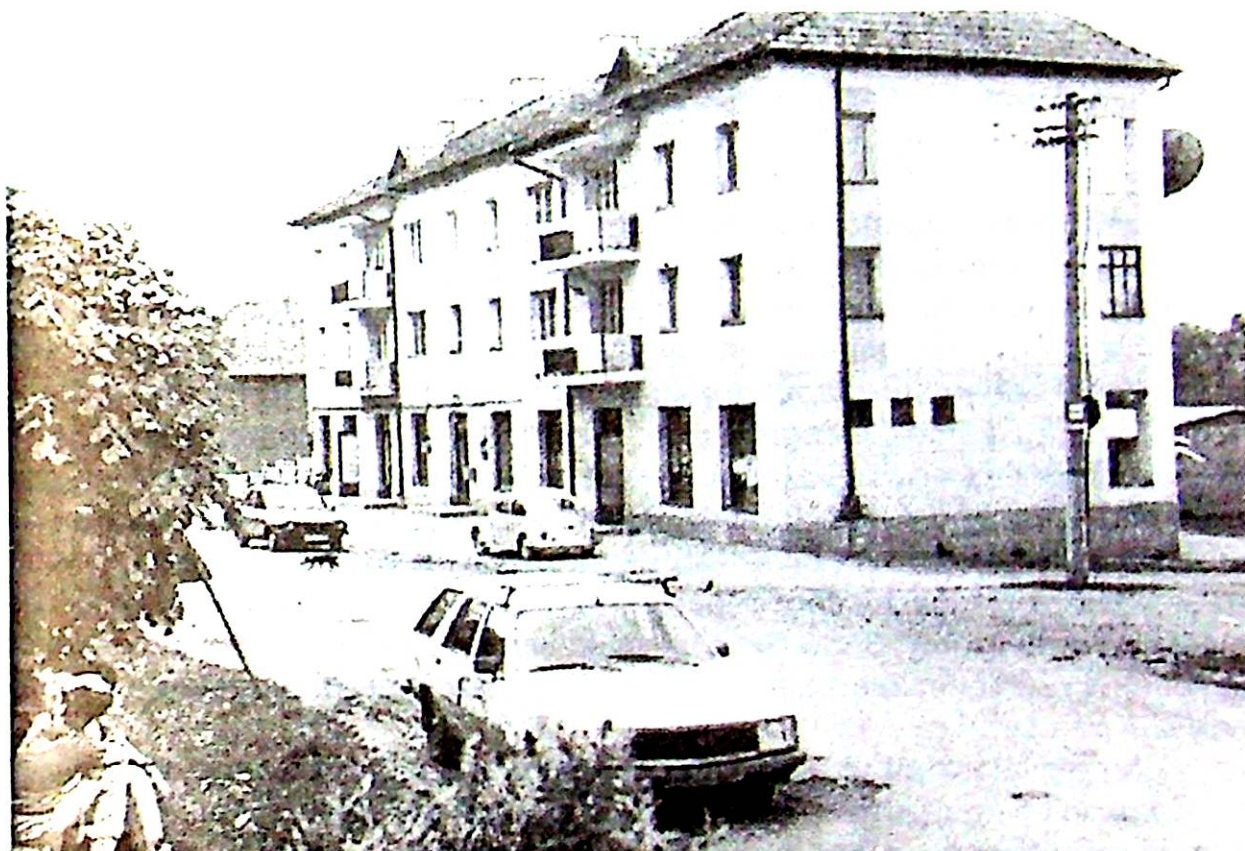
Állami költségen épített emeletes háztömb
