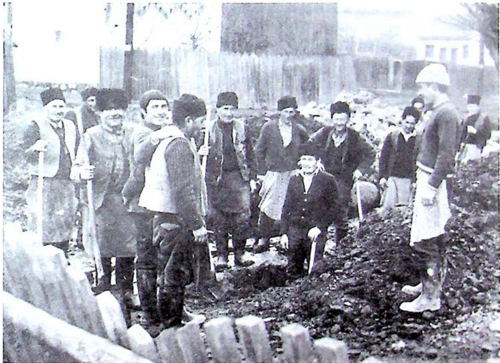
Közmunka a Tósára-pataknál - 1970-es évek
