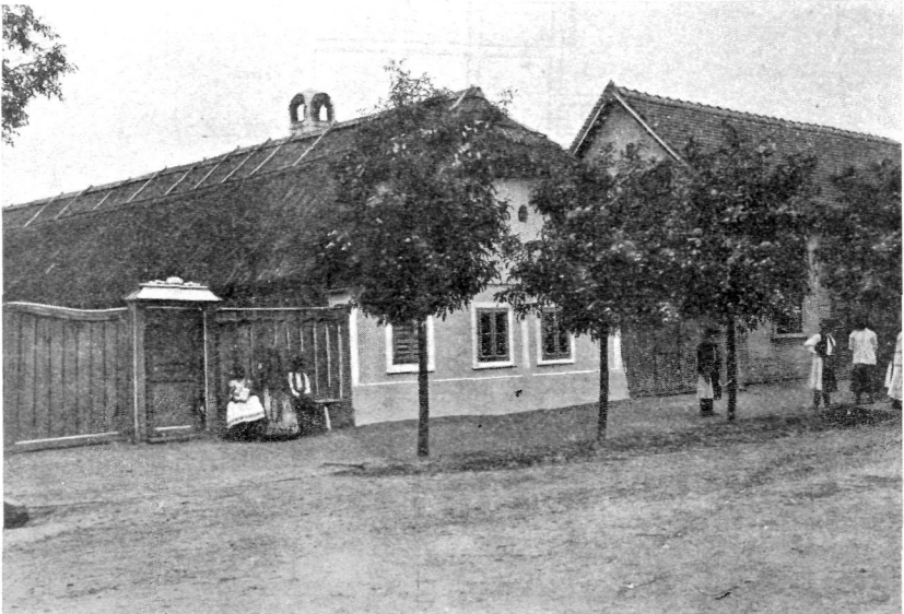
39. ábra. Erdőhegyi ház deszka kerítéssel.
