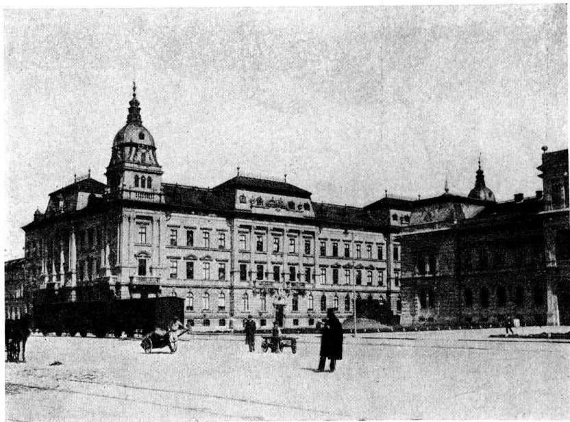
Városház-tér, északi oldalán Arad-Csanádi Egyesült Vasútak díszes épülete, tervezték : Ybl-Jiraszek.
